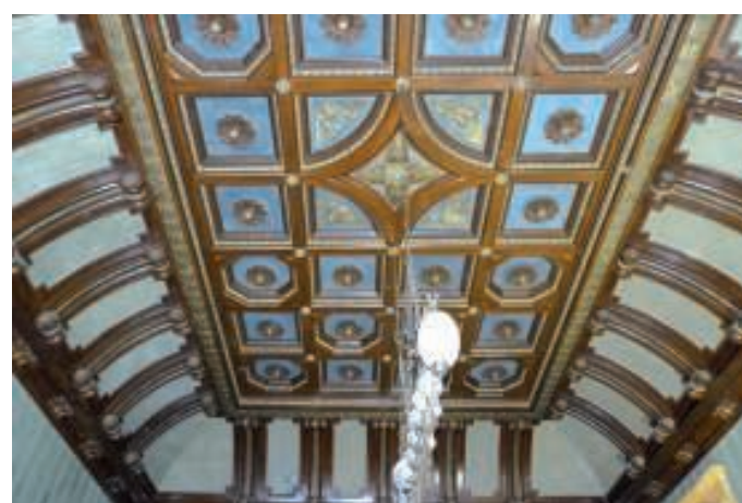
Inaugurazione a maggio. Lavori intanto ultimati per quanto riguarda i soffitti
